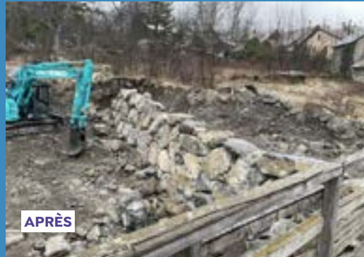
Protection de berges en rive gauche du Gros Riou (Prelles)
