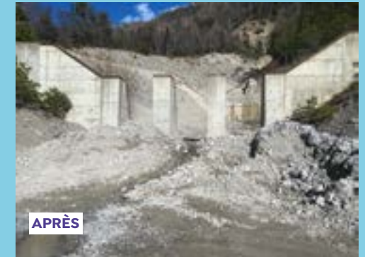
Curage du peigne à matériaux (L'Argentière-La Bessée)
