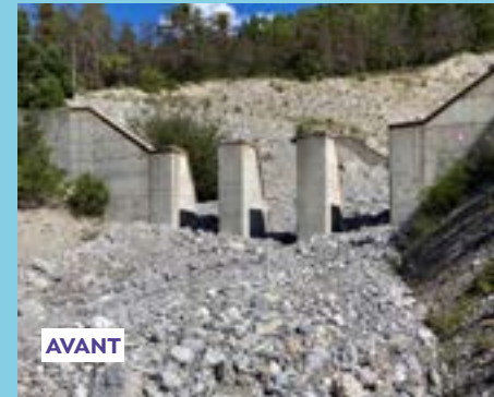
Curage du peigne à matériaux (L'Argentière-La Bessée)
